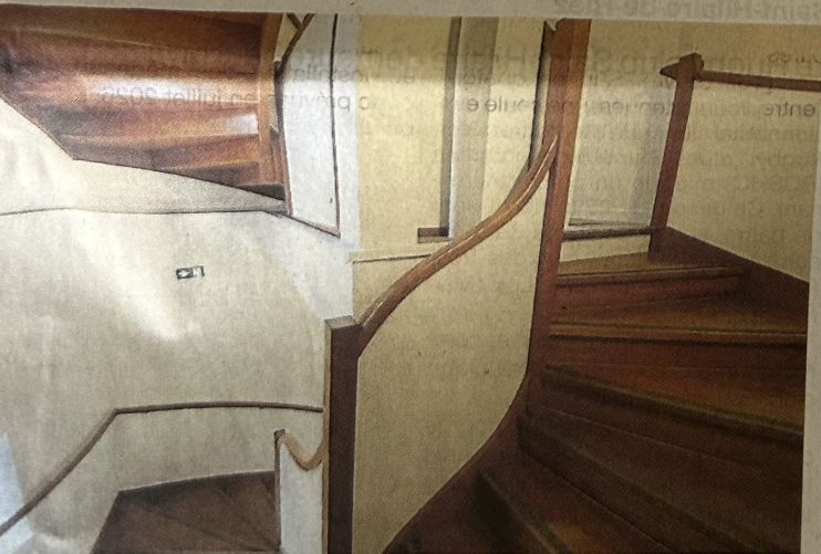
« Cet escalier a nécessité 15 jours de travail en atelier et trois jours pour la pose. »
